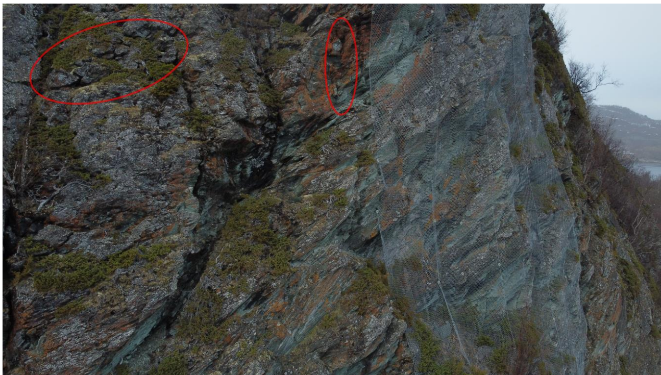
Foto 7 Detaljbilde fra Talviktunnelen påhugg sør, røde markering viser bergsikringsbehov, i utgangspunktet rensk.
