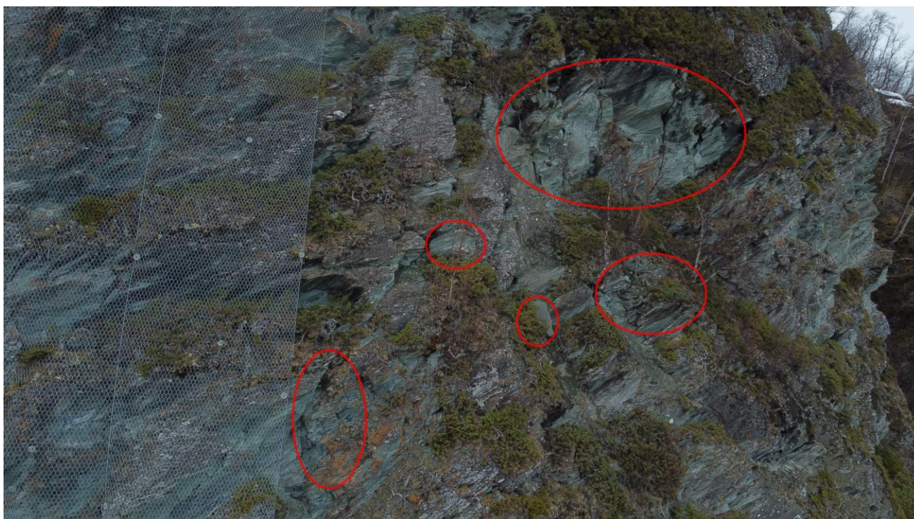
Foto 5 Detaljbilde fra Talviktunnelen påhugg sør, røde markering viser bergsikringsbehov, i utgangspunktet rensk.
