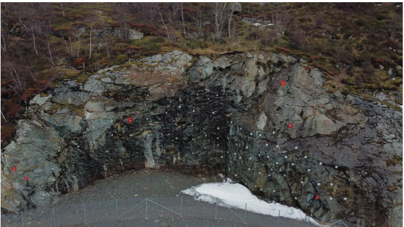
Foto 2 Røde markeringer viser vrakbolt ved forskjæring og påhugg ved Talviktunnelen nord.
