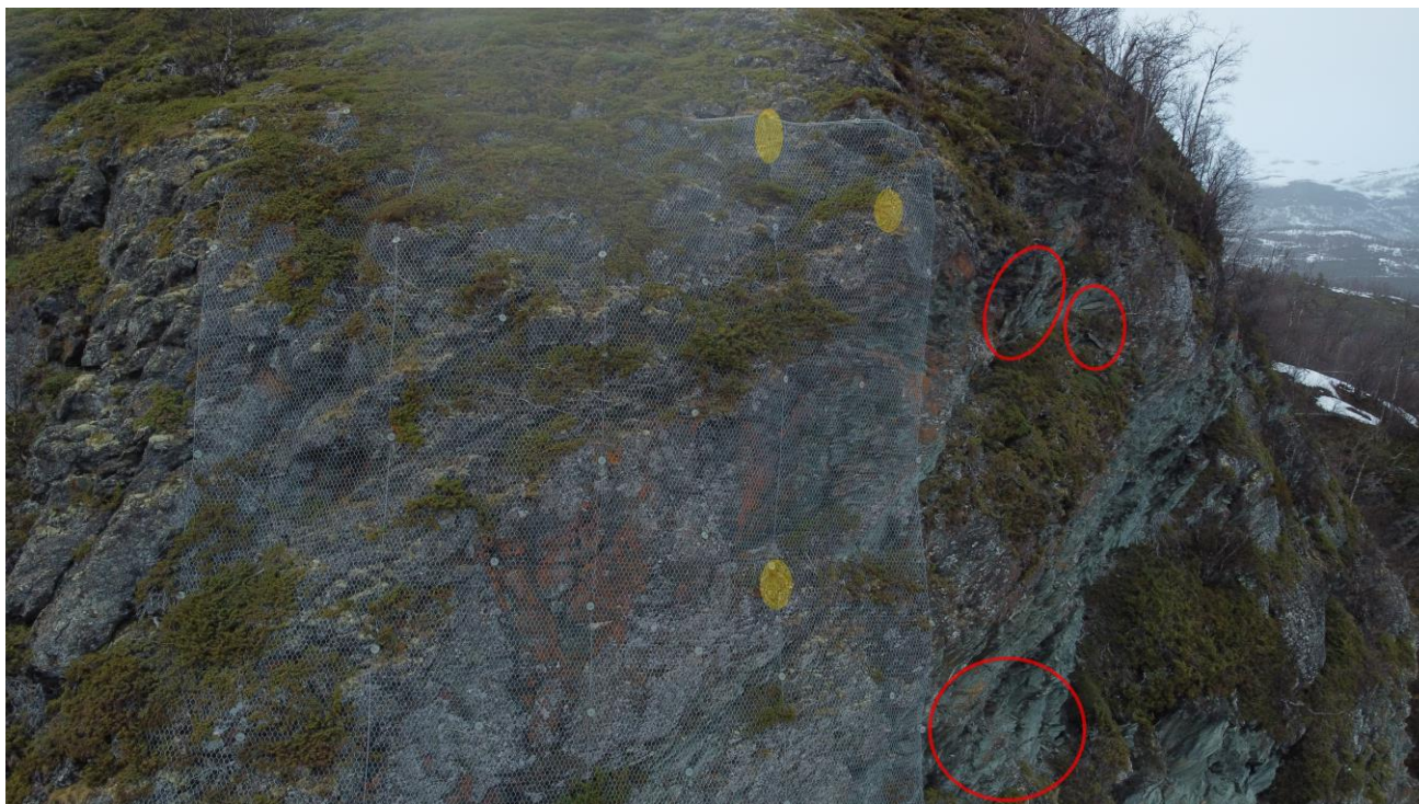
Foto 4 Detaljbilde fra Talviktunnelen påhugg sør, røde markering viser bergsikringsbehov, i utgangspunktet rensk. Gule markeringer viser behov for reparasjon på steinsprangnett.
