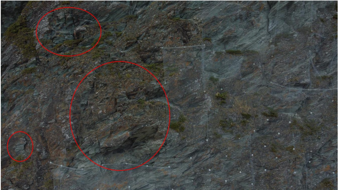
Foto 8 Detaljbilde fra Talviktunnelen påhugg sør, røde markering viser bergsikringsbehov, i utgangspunktet rensk.
