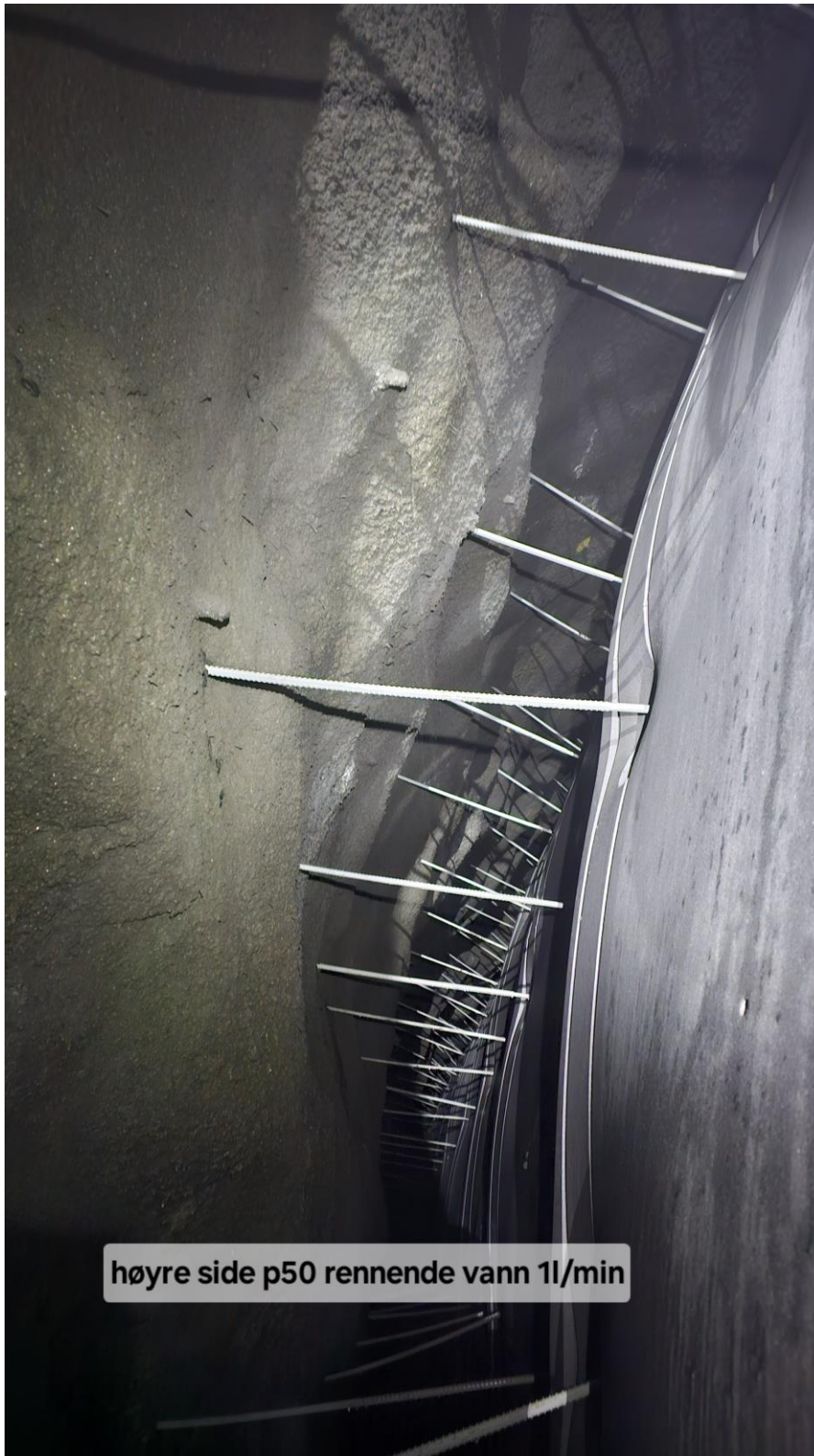
Foto 10 Bak hvelv høyre side pel 50. Rennende vann fra sprekk i sprøytebetong. Ca. 1 l/min.
