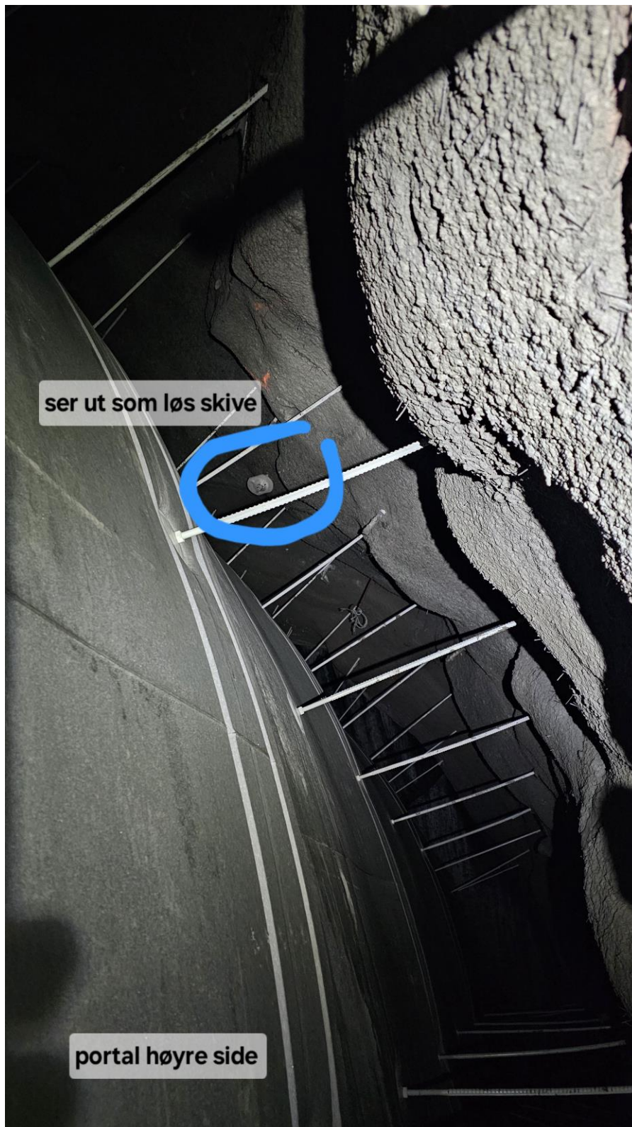
Foto 14 Bak hvelv ved portal i sør høyre side. Observert løs skive.
