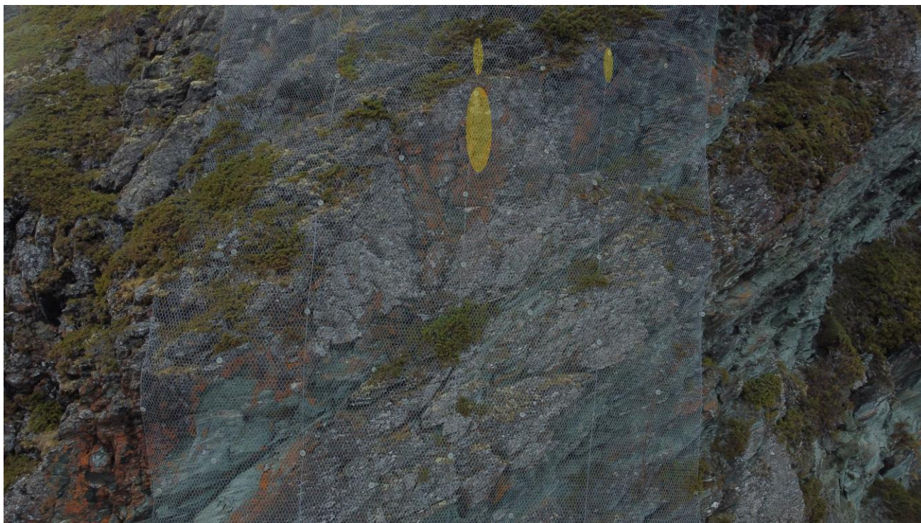
Foto 6 Detaljbilde fra Talviktunnelen påhugg sør. Gule markeringer viser behov for reparasjon på steinsprangnett.
