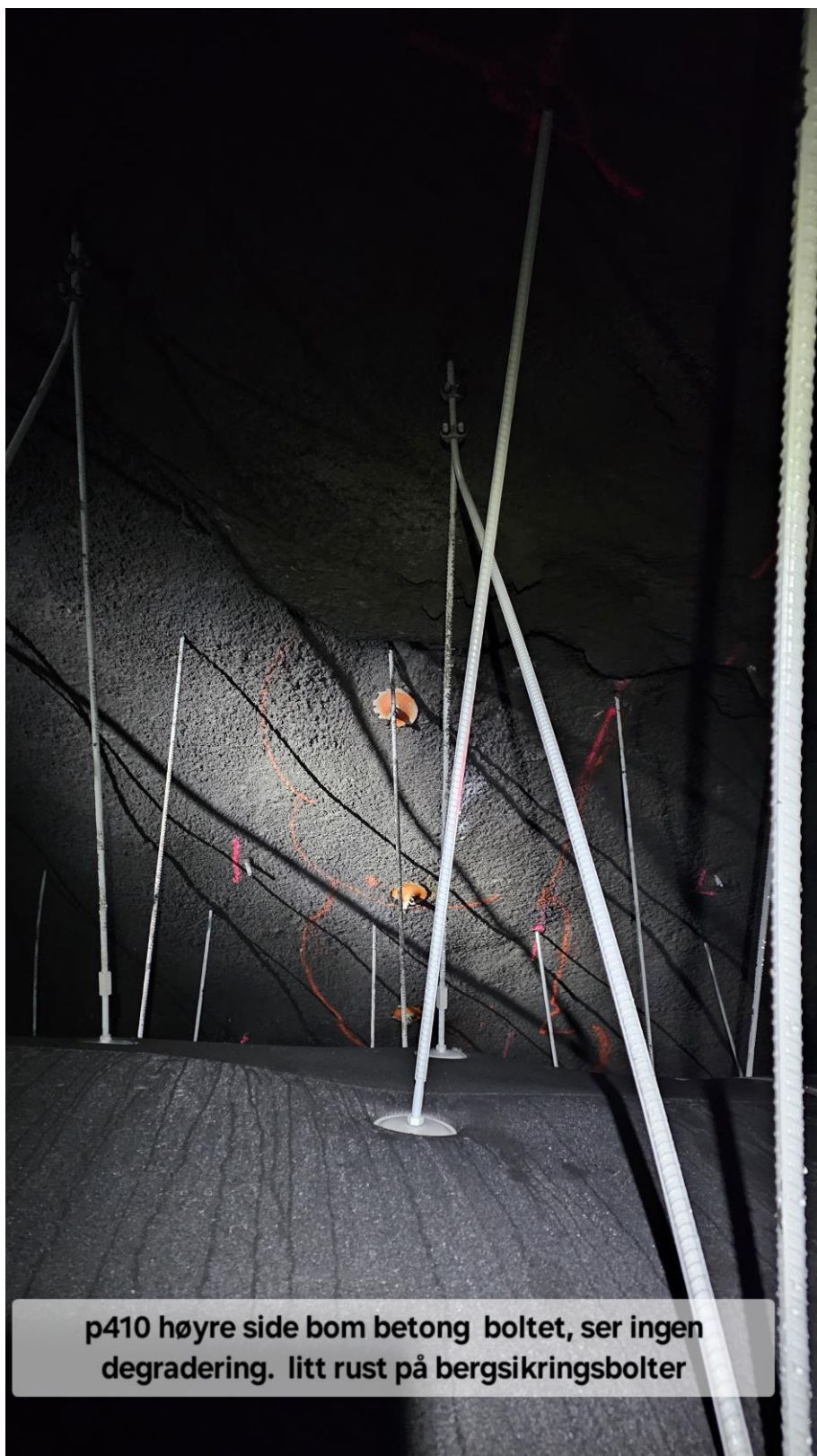
Foto 12 Bak hvelv høyre side pel 410. Registrert bom, men ikke observert degradering. Det er noe rust på bergsikringsboltene.
