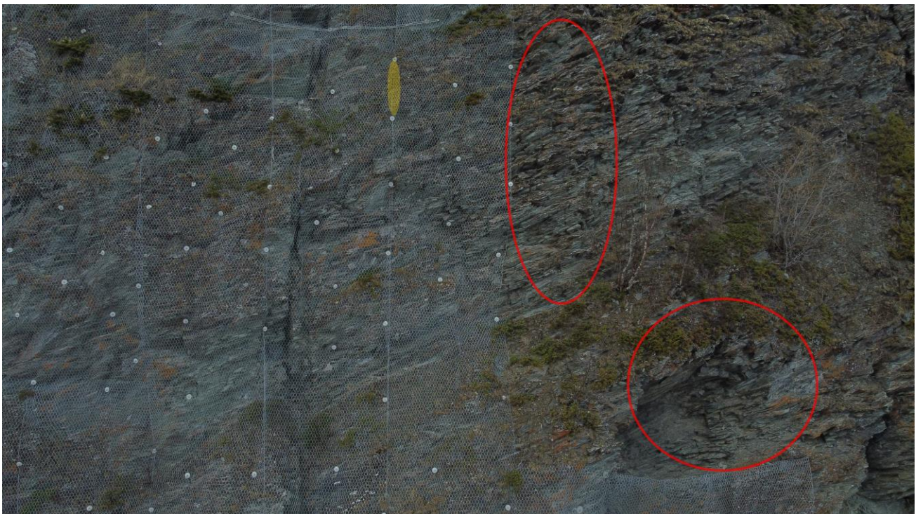
Foto 9 Detaljbilde fra Talviktunnelen påhugg sør, røde markering viser bergsikringsbehov, i utgangspunktet rensk. Gule markeringer viser behov for reparasjon på steinsprangnett.
